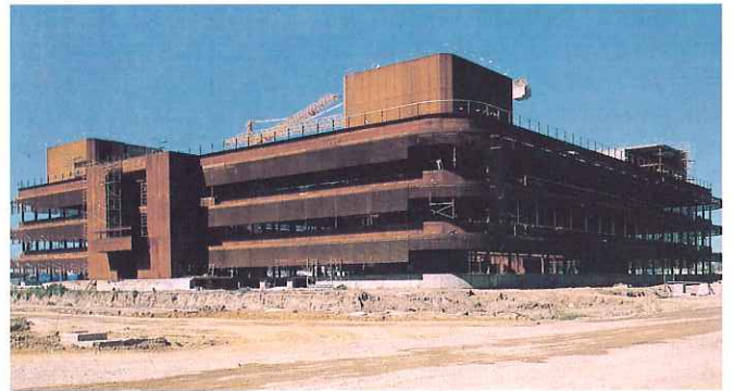
El edificio Expo está prácticamente terminado.
