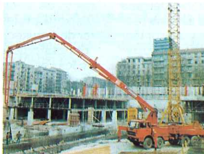
BOMBAS DE HORMIGONAR SOBRE CAMION
