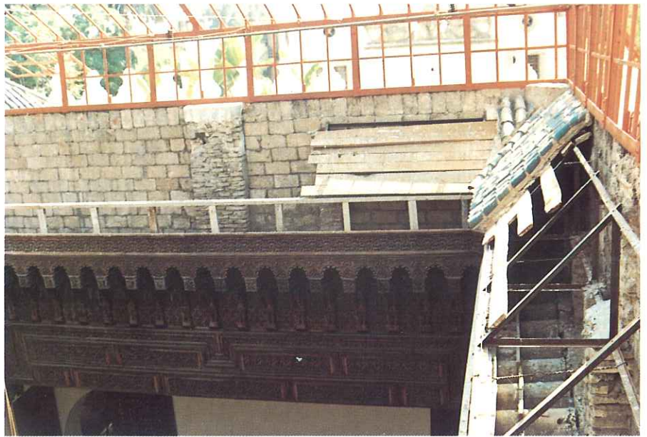
Parcial constructivo del pabellón.
