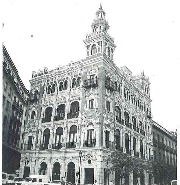
Edificio Telefónica (Plaza Nueva)
