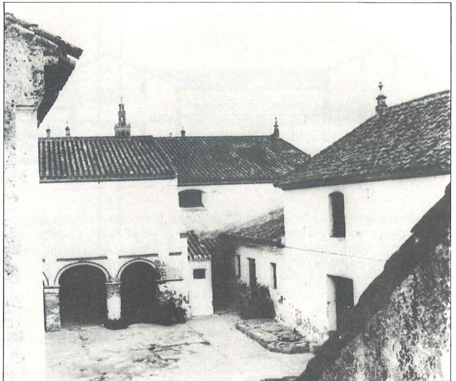
Estado inicial. Patio de labor.
