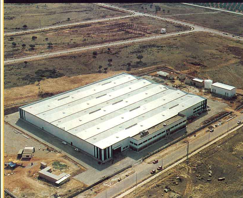
C.M.B. - ENVASES, S. A. Nueva Factoría en Polígono Industrial de Guadiel-Guarromán (Jaén) 15.000 m 2 de Cubiertas y Fdas. SANDWICH
