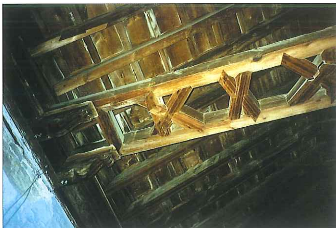
Armadura mudéjar con tirantes pareados y apeinizados apoyados sobre canes tallados (s. XVI)
