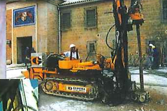
Inyecciones para consolidación del Parador de Carmona (Sevilla)
