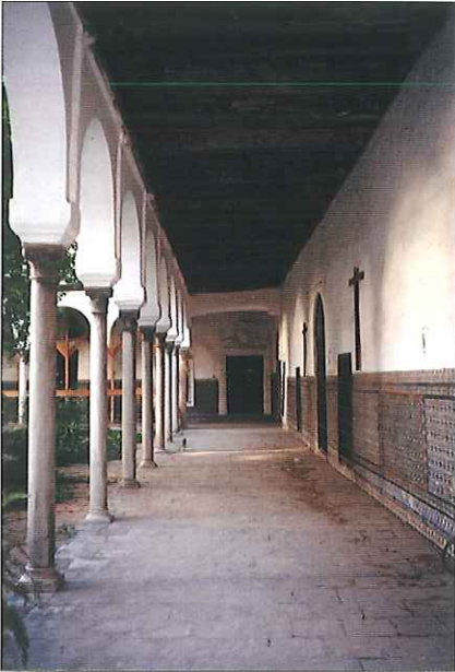
Interior de la panda baja del claustro
