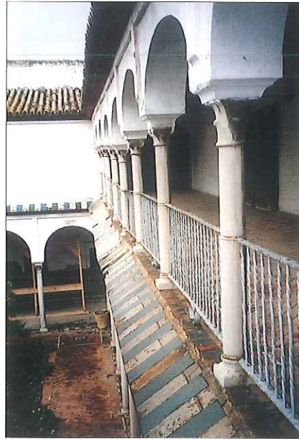
Detalle: galería abierta de la planta alta
