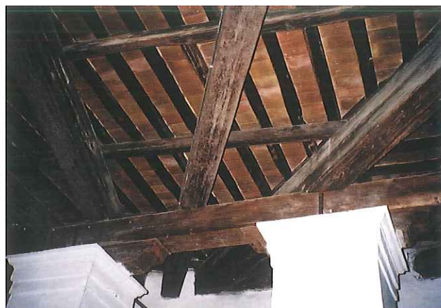
Abanicado de vigas apoyadas sobre carrera y zapatas (s. XVII)
