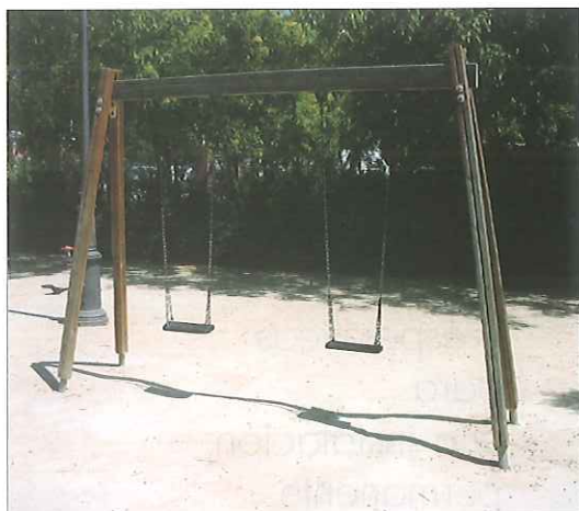
Columpio con un eje de rotación (Tipo 1). La norma solamente permite dos asientos por travesaño NORMA UNE-EN 1176. PARTE 2
