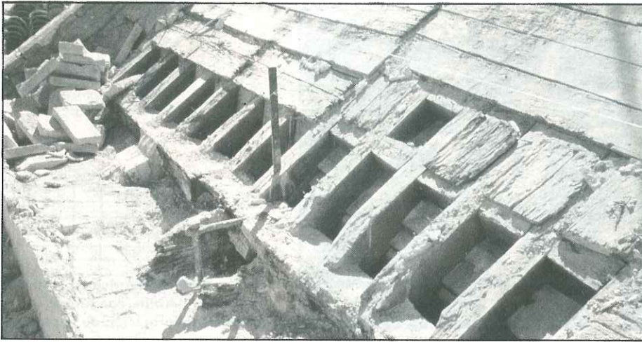
Detalle del apoyo de los pares. Nótese al grado de deterioro del estribo y el «simbólico» anclaje del tirante de hierro en el muro.
