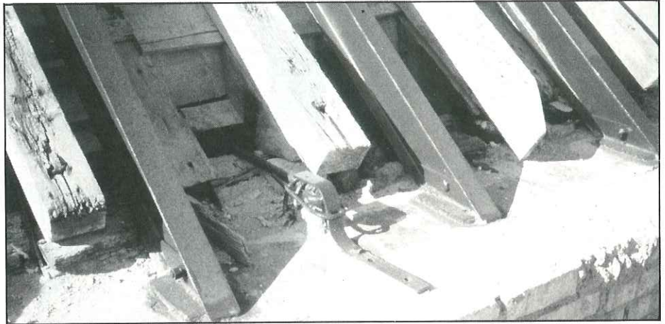
La precisión geométrica de la nueva estructura permite comprobar al alto grado de deformación de la antigua.
