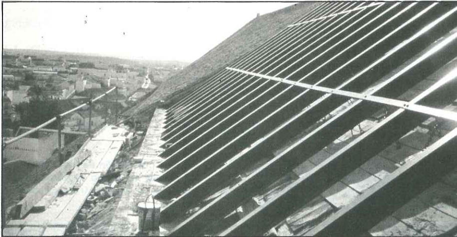
Detalle del mismo anclaje.
