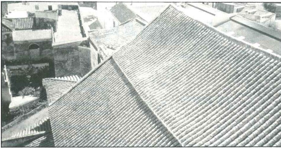
Aspecto que presentaban las cubiertas antes de la intervención. Nótese el importante hundimiento en la zona que se señala mediante una flecha.
