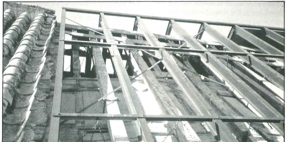
La nueva estructura de perfiles de acero. En esta fotografía se aprecia claramente al alcance parcial de la intervención. La parte de cubierta que aparece con tejas no ha sido tocada en esta intervención.
