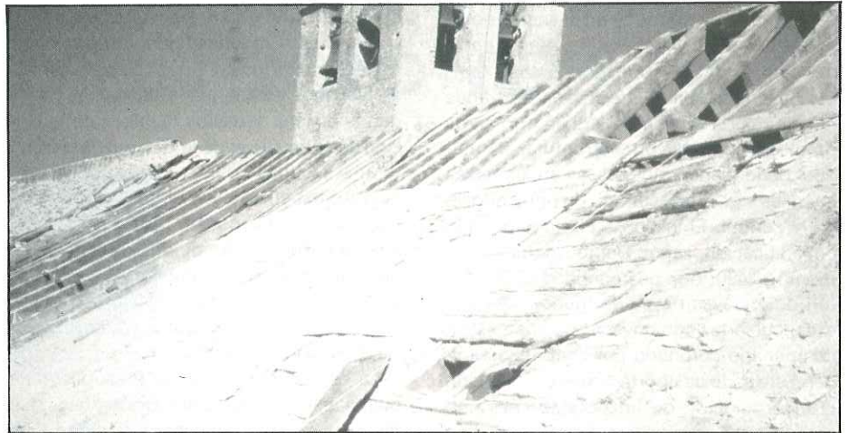
Aspecto que presentaban las cubiertas antes de la intervención. Nótese el importante hundimiento en la zona que se señala mediante una flecha.
