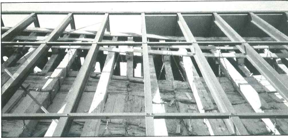
La precisión geométrica de la nueva estructura permite comprobar al alto grado de deformación de la antigua.
