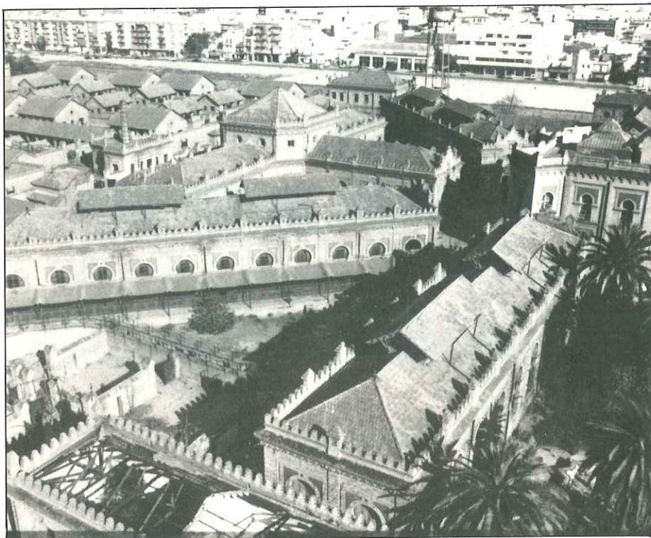
Vista general del matadero.
