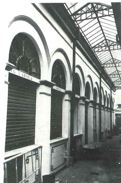
Terminación de la restauración de la cuartelada n.º 1 (abril de 1983)
