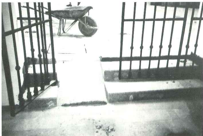
Rampa granítica colocada en todos los desniveles de acceso a las cuarteladas
