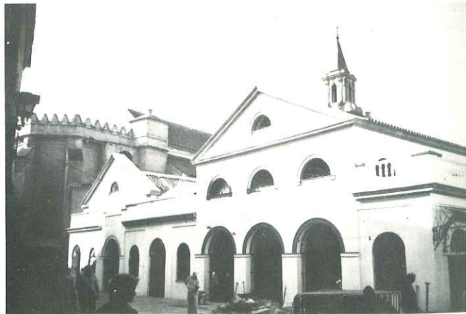
Vista parcial antes de la recepción de la segunda fase de restauración del mercado
