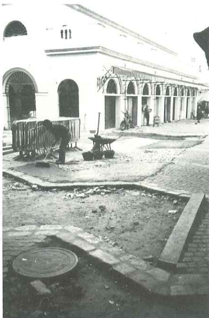
Pavimentación de la calle Calderón de la Barca
