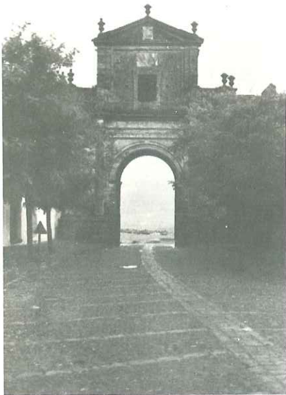
Puerta de Córdoba, desde el interior del casco. Su estado actual data de 1688
