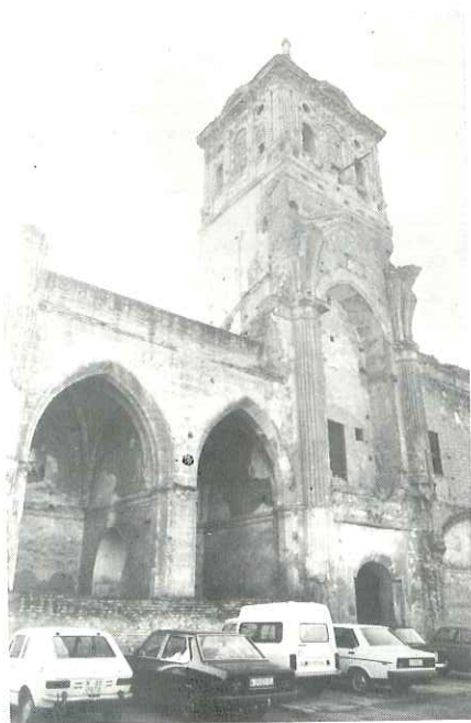
Restos de la iglesia y torre desde la entrada al recinto
