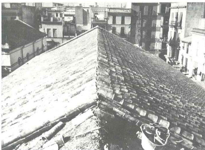
Ejecución del material de cubrición de la cuartelada del pescado (n.º 3)
