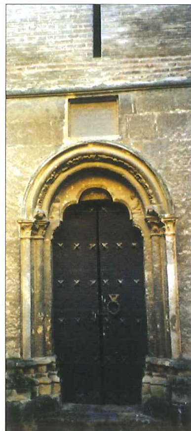
Portada de la torre del palacio
