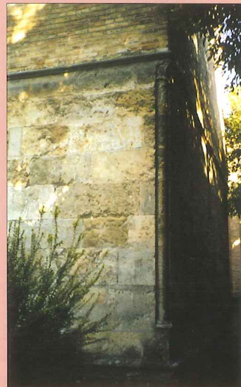
Detalle de una esquina. Planta baja de la torre del Palacio.
