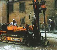
Inyecciones para consolidación del Parador de Carmona (Sevilla)
