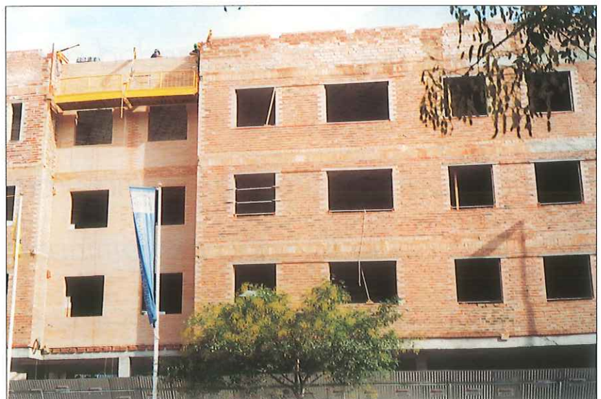
Barandilla telescópica de mordaza para protección huecos verticales de ventanas y balcones (Huecos de 0.80 a 1.20 m)
