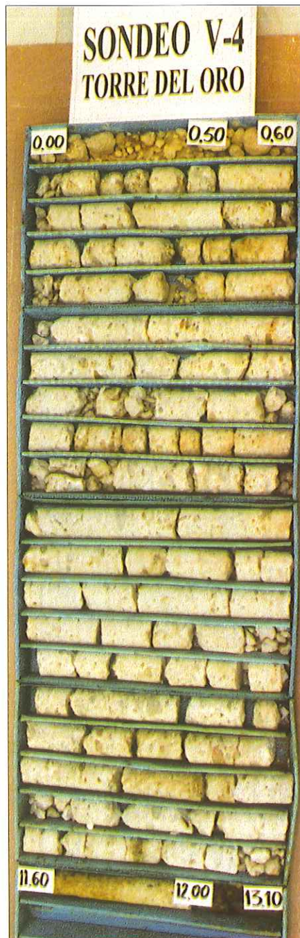
▲ Muestras correspondientes al sondeo realizado en la actual entrada de la Torre. Las muestras de hormigón de cal corresponden al macizado del nivel inferior (6m) realizado posiblemente en la intervención de 1.760, más el correspondiente a la cimentación (5m)
