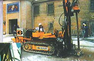
Inyecciones para consolidación del Parador de Carmona (Sevilla)
