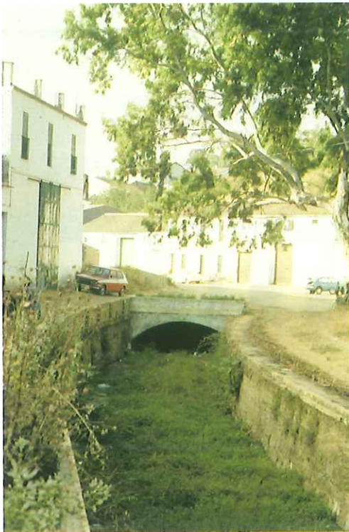
Zona del Rihuelo, donde el río de la Villa ha sido cubierto en la última de las obras de este tipo realizadas en los siglos XIX y XX.
