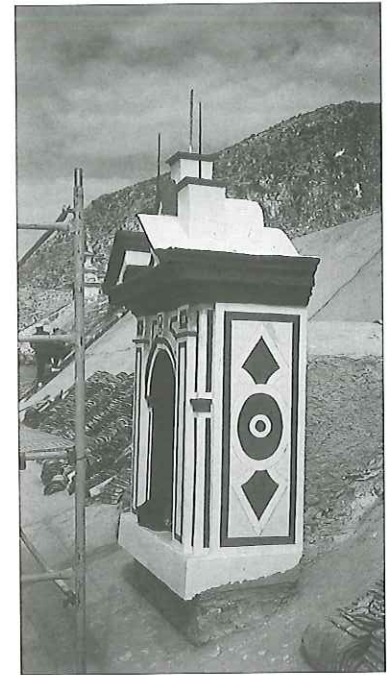
Estado restaurado de una de las mansardas de la nave central
