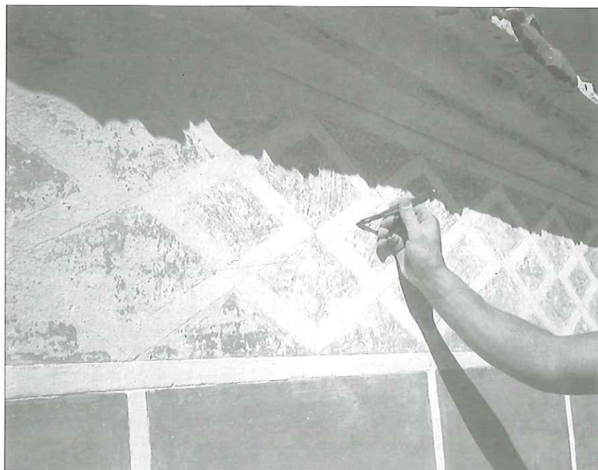
Prueba de limpieza con bisturi de las cenefas existentes
