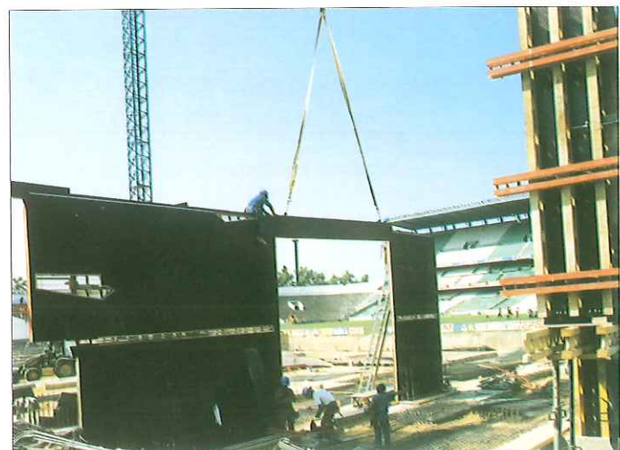
Distintas imágenes de la obra durante el montaje y construcción del Graderío del Gol Norte.
