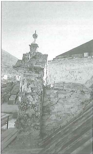
Estado original de una de las mansardas de la nave central
