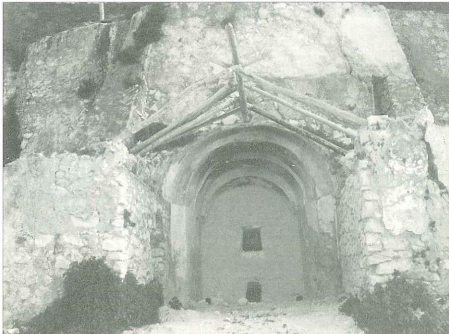
**Foto 3.** Horno de cal cargado. En la parte baja se puede apreciar el hueco de entrada de combustible y el inferior para la entrada del aire, que crea una corriente ascendente del calor. En la parte superior se ve la bóveda de piedra caliza ya terminada.
