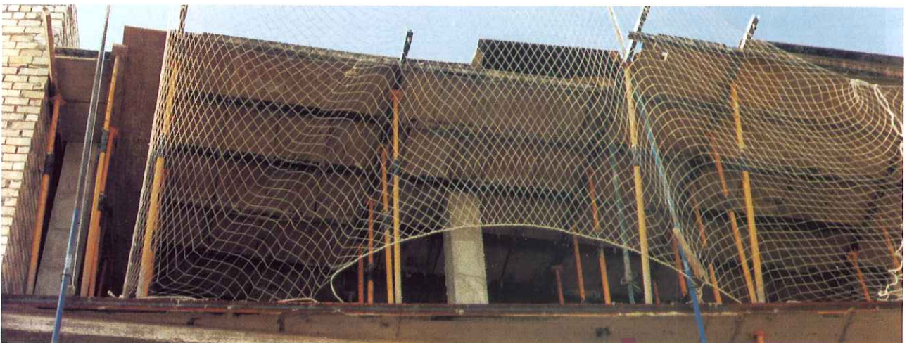
Red con soportes de horca, abierta por su parte inferior. Es imaginable la secuencia completa en el caso de accidente de caída de una persona desde altura.
