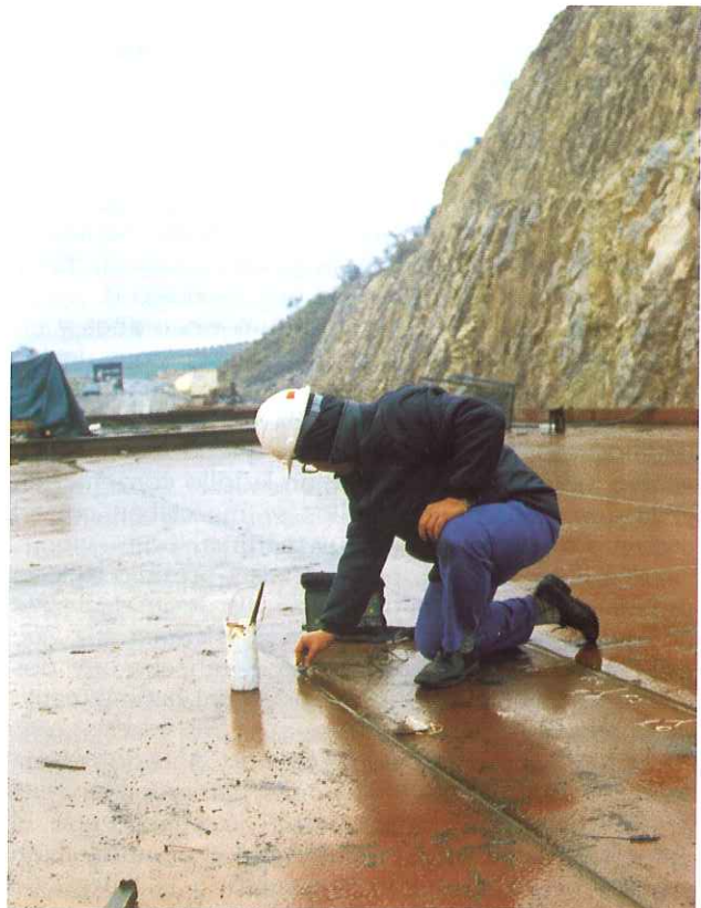
Detección por ultrasonidos de defectos en soldaduras.
