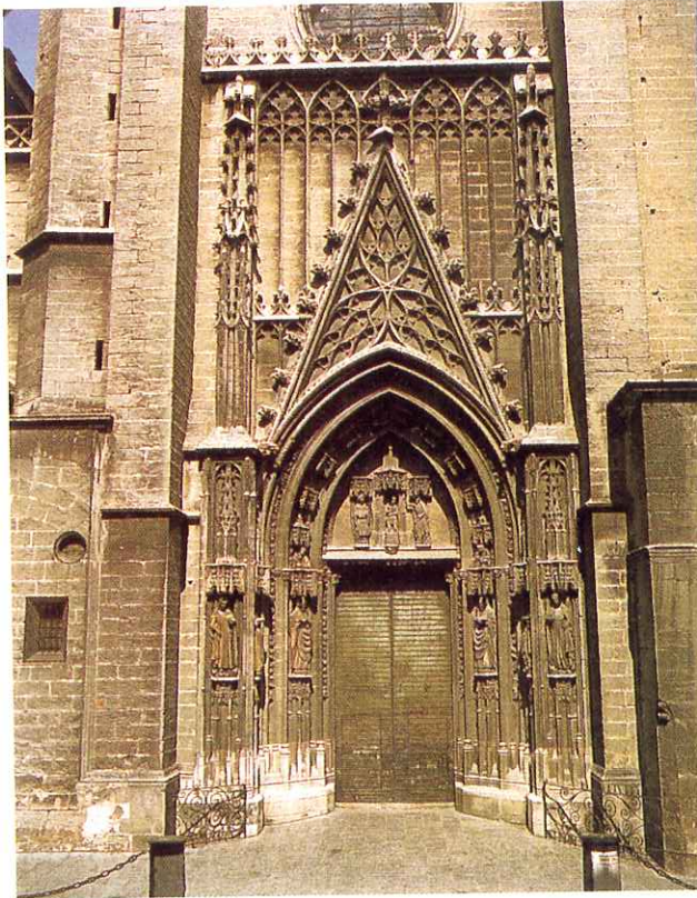
Portada del Bautismo de la Catedral de Sevilla. Aunque resulta difícilmente perceptible, sus elementos decorativos están recubiertos de una finísima red que evita el posamiento de aves.
