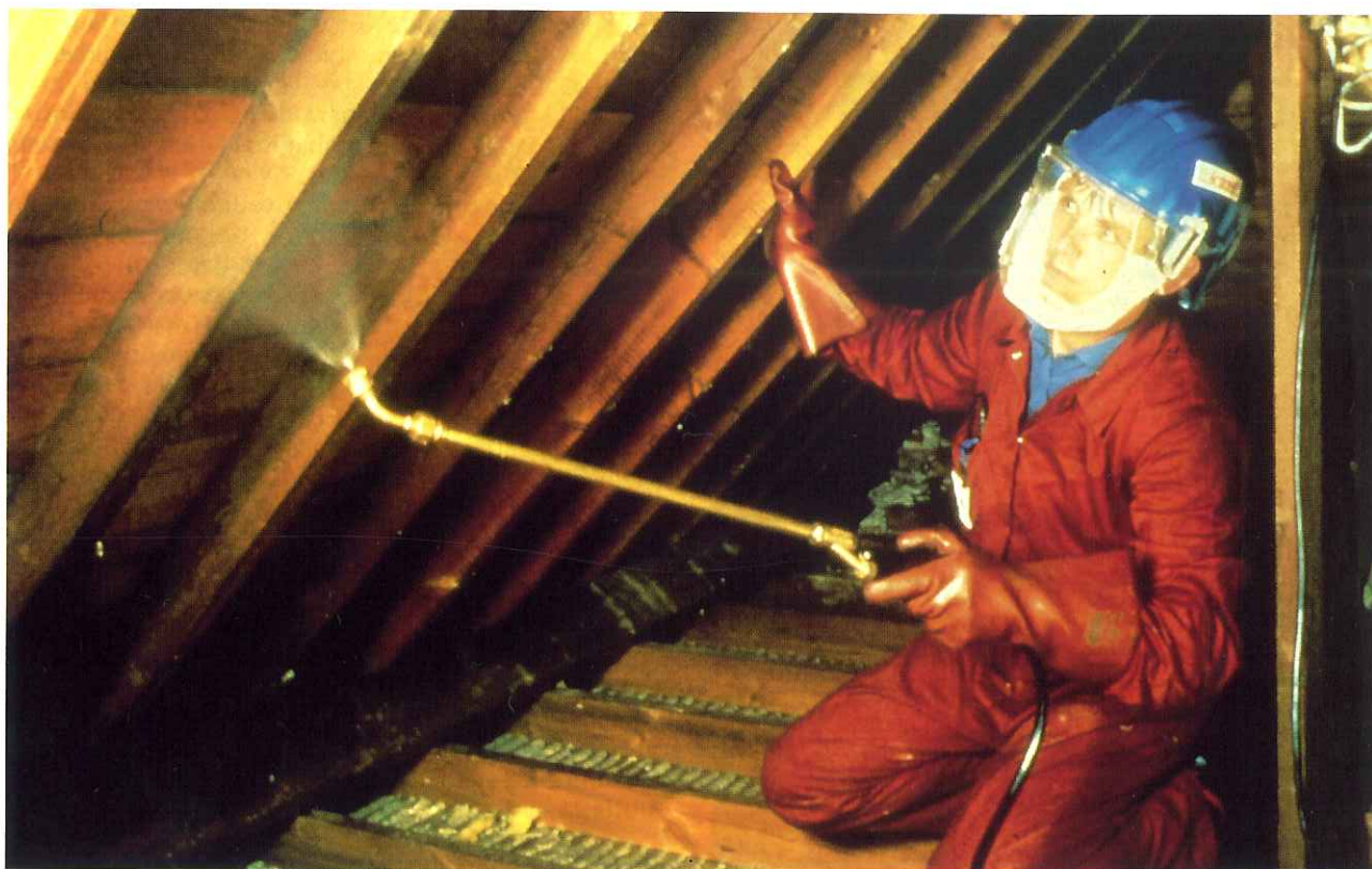
Imprimación superficial de insecticidas para control de la carcoma.
