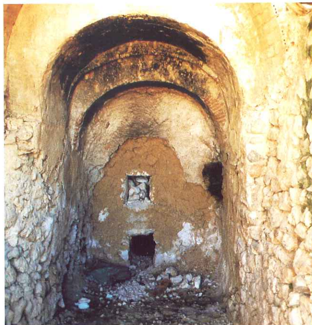
Vista interior de un tradicional horno de cal de Morón.
