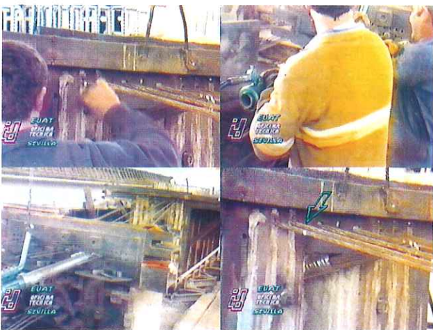
Fig. 2. Procedimiento de tesado en vigas pesadas. La flecha de diseño muestra el desplazamiento del trazo, realizado previamente por el operario, con la aplicación del equipo de tesado que se observa en las imágenes intermedias.
