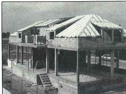
Forjado de sótano, primera planta y cubierta realizada con bovedillas de poliestireno. Propietario: D. José PERSONAL. Situación: Condequinto (Sevilla)
