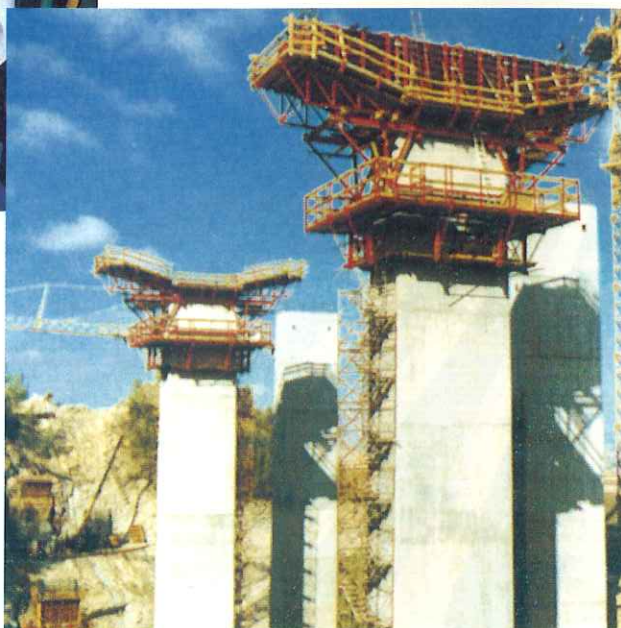
Encofrados en la autovía Málaga-Antequera.
