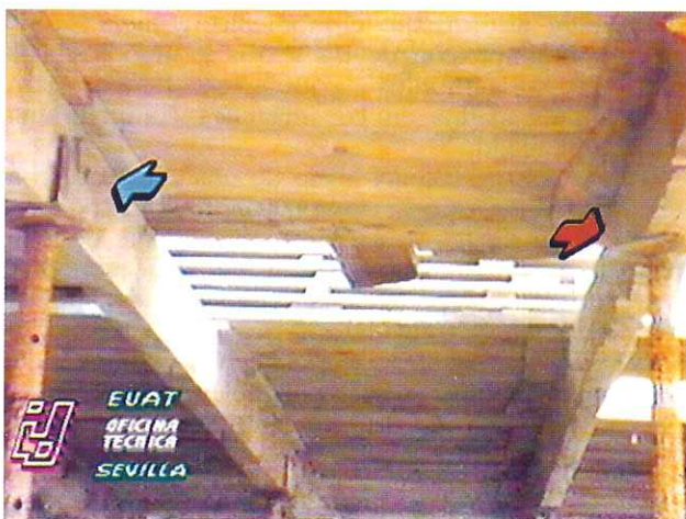
Fig. 6. Apuntalamiento de encofrado. La coloración dada a las flechas, permite distinguir la correcta o incorrecta disposición del puntal, sustentando al costero dispuesto de canto.
