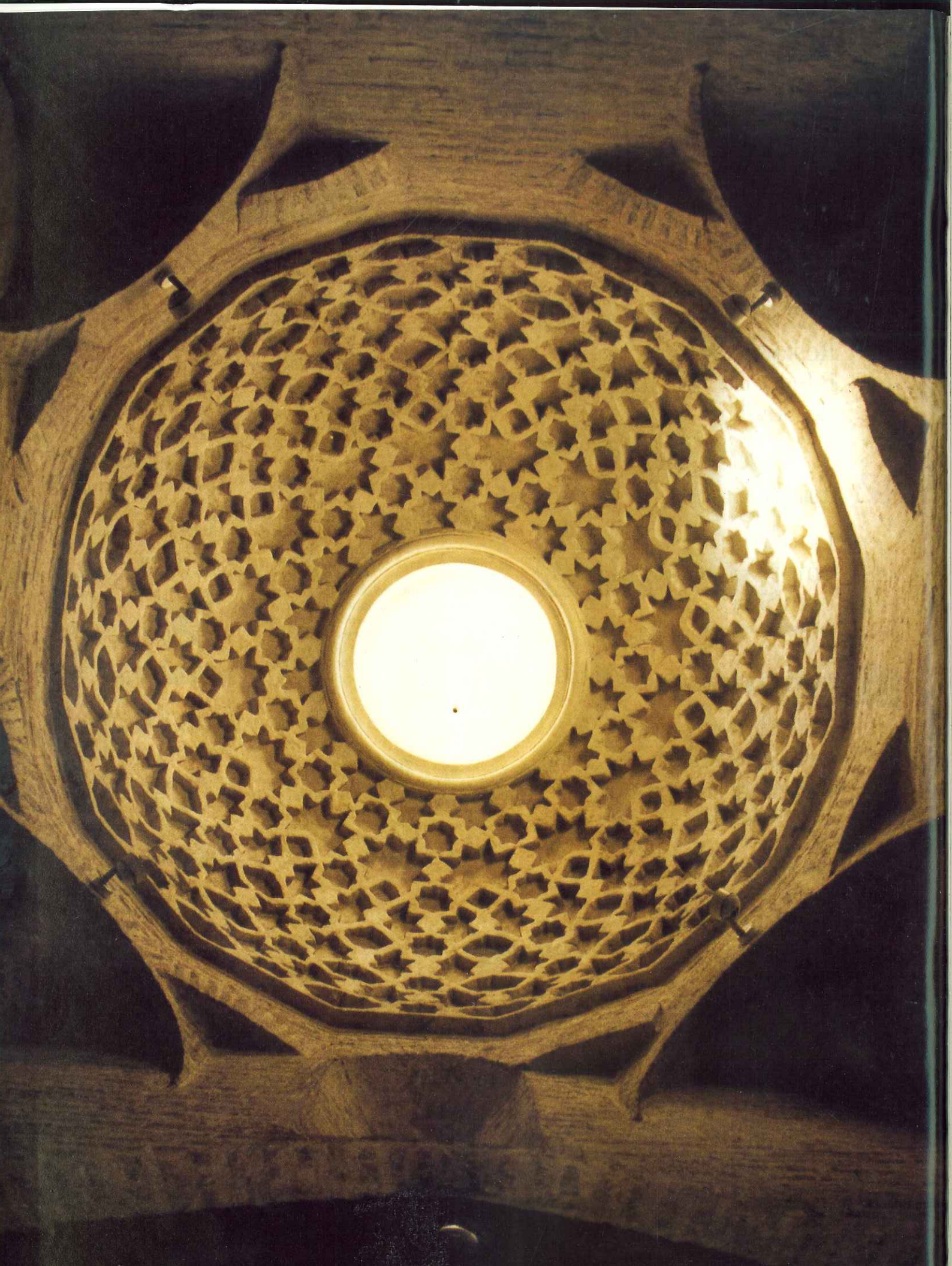
Esta cúpula con decoración mudéjar cubre la capilla ahora presidida por la imagen de Ntra. Sra. de la Salud. Fue descubierta durante los trabajos de restauración del templo. Antes estaba oculta por una falsa bóveda que simulaba un cielo tachonado de estrellas. La linterna, abierta en el centro del techo original en época muy posterior a su construcción, ha sido respetada.
