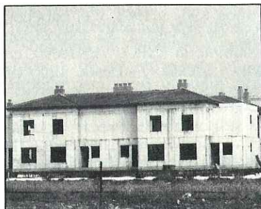
150 viviendas construidas con paneles de poliestireno expandido como encofrado perdido. Propietario: COVIFALSE. Políg. Sevilla-Este. Arquitecto: D. Matías ACOSTA CASADO.
