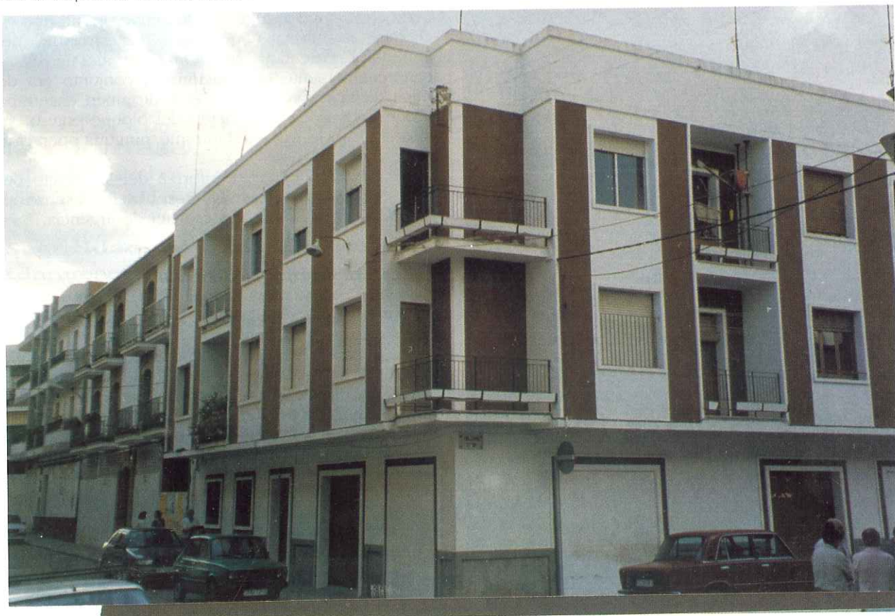
Vista de conjunto del inmueble, situado en la confluencia de las calles Cristóbal Colón e Hilario Angel Calero.
