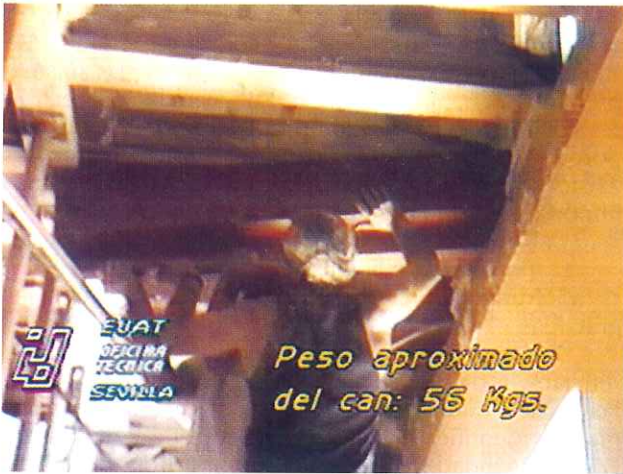
Fig. 4. Refuerzo de vigueta de madera de apoyo. El rótulo, indica el peso de la prótesis que se coloca reforzando el extremo de la vigueta, introducción en el muro.
