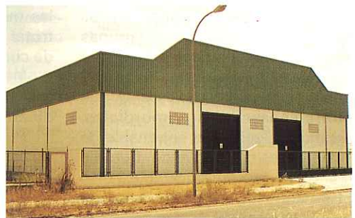
Nave Industrial construida para NACOISLA, S. L.
