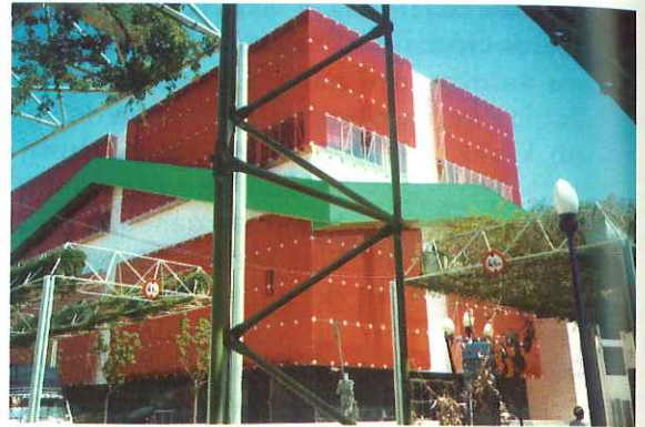
Pabellón EUSKADI Entrecanales y Távora, S. A.
