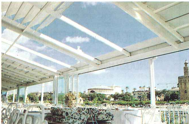
Instalación realizada en: RESTAURANTE RIO GRANDE (SEVILLA)
