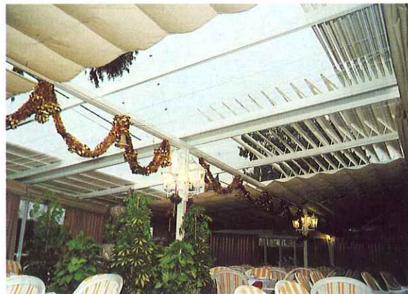
Instalación realizada en: RESTAURANTE EL BARCO (GINES-SEVILLA)
