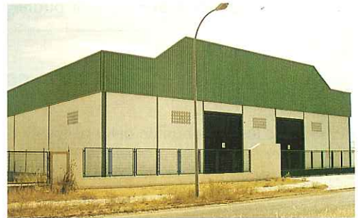
Nave Industrial construida para NACOISLA, S. L.
