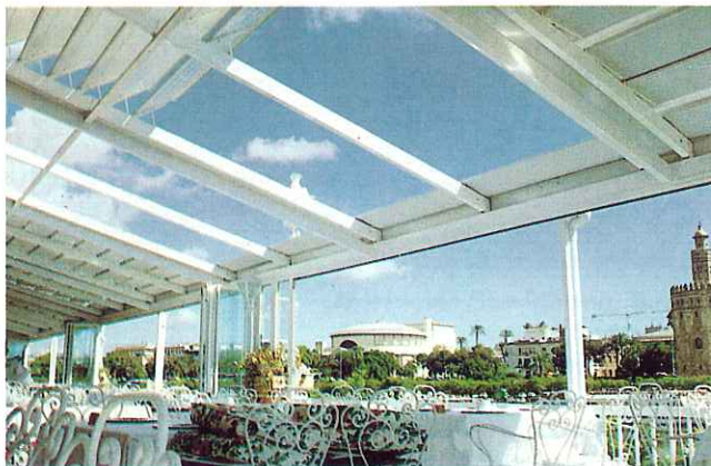
Instalación realizada en: RESTAURANTE RIO GRANDE (SEVILLA)
