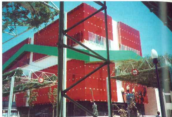
Pabellón EUSKADI Entrecanales y Távora, S. A.
