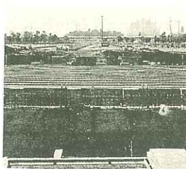
PUENTE SOBRE LAGO ARTIFICIAL EXPO'92
