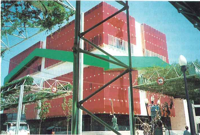
Pabellón EUSKADI Entrecanales y Távora, S. A.
