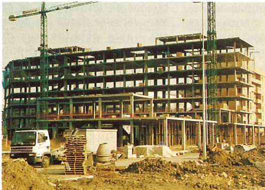
Construcción Edificio de 36 viviendas para LA COMPAÑIA DE MADERAS, S. A.
