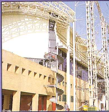
Pabellón del Futuro - EXPO'92
