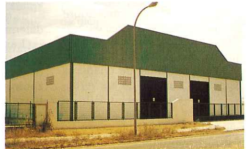
Nave Industrial construida para NACOISLA, S. L.
