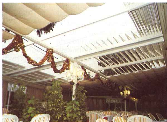
Instalación realizada en: RESTAURANTE EL BARCO (GINES-SEVILLA)
