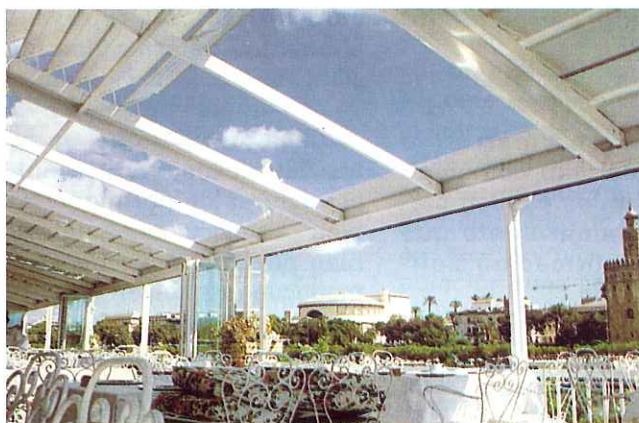
Instalación realizada en: RESTAURANTE RIO GRANDE (SEVILLA)
