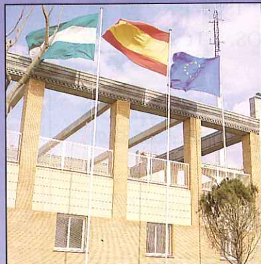
Subestación VC - EXPO'92
