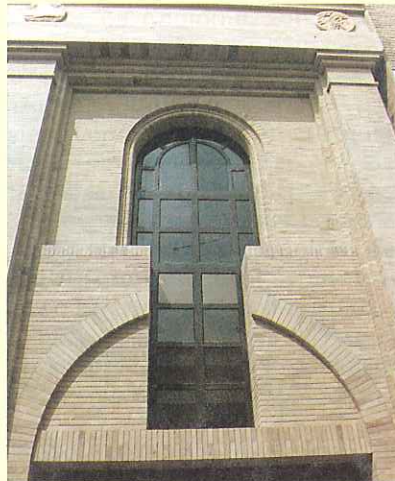
Detalle de ventana en palillería en aluminio lacado (Ayuntamiento Puebla del Río).
