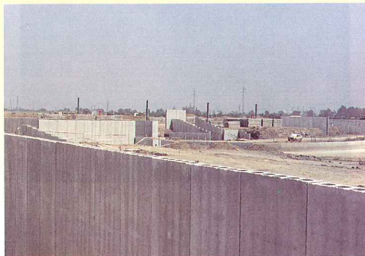
Placas CIRAL sobre jácenas metálicas en obra Aeropuerto de Jerez, con detalle de corte de pilares y taladro.
