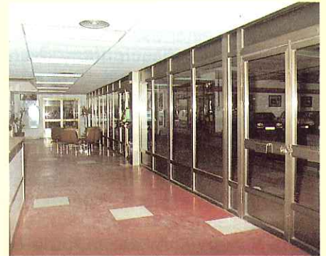
Instalación en Casa Citroën Viuda de Mariano Terry. División de oficinas en aluminio bronce y techo Armstrong.
