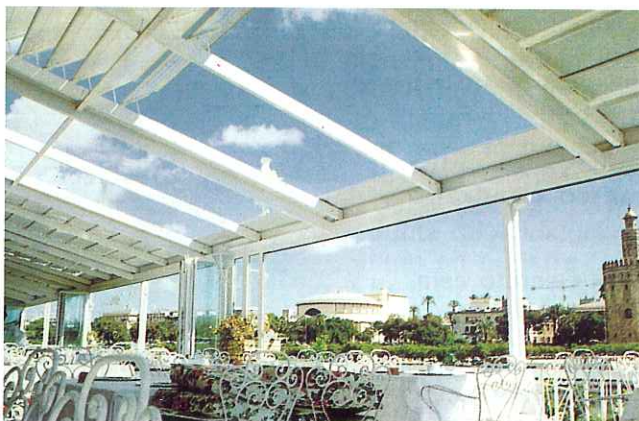
Instalación realizada en: RESTAURANTE RIO GRANDE (SEVILLA)
