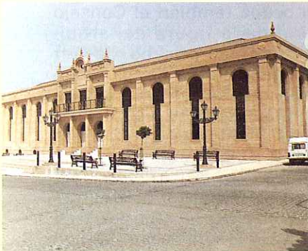
Excmo. Ayuntamiento de Puebla del Río montaje de carpintería en aluminio lacado.
