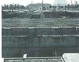
PUENTE SOBRE LAGO ARTIFICIAL EXPO'92
