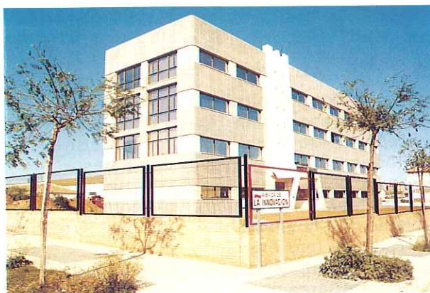
(Edificio INNOVA), Construcción realizada por D.A.E. CONSTRUCCIONES a las empresas Toscano/Tei.
