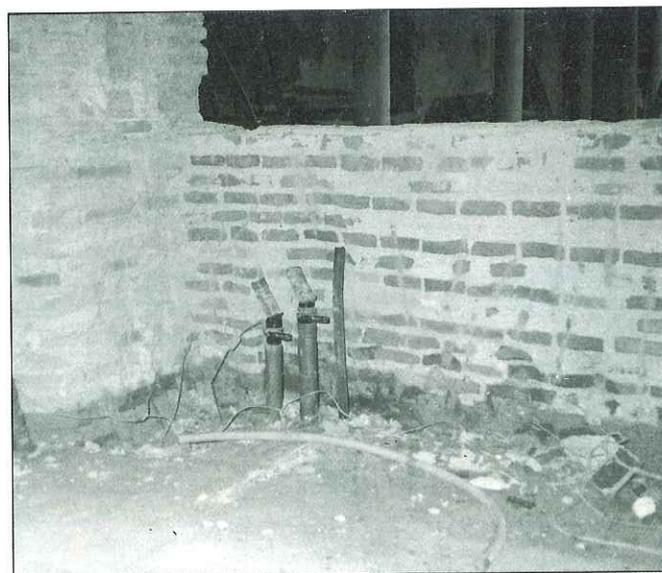
Muro seccionado longitudinalmente por necesidades de obra, después de aplicar el sistema de electro-ósmosis-fóresis.
