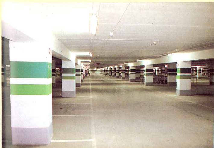
Vista parcial, jacenas y placas CIRAL. Aparcamiento Alcampo, Ronda de Tamarguillo. Sevilla.
