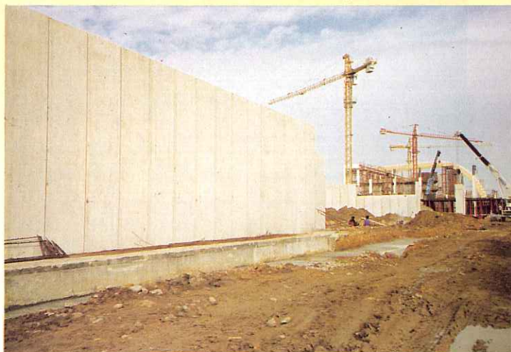
Placas en muro de contención, altura 6,40 mt. Puerta fluvial Expo-92.
