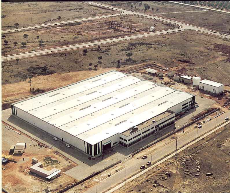
C.M.B. - ENVASES, S. A. Nueva Factoría en Polígono Industrial de Guadiel-Guarromán (Jaén) 15.000 m 2 de Cubiertas y Fdas. SANDWICH
