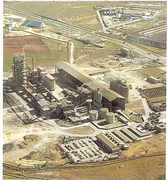
Fábrica Alcalá de Guadaira (Sevilla)
