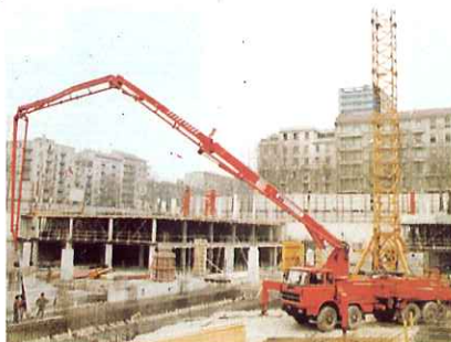
BOMBAS DE HORMIGONAR SOBRE CAMION
