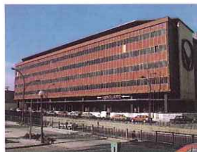
Santa Eulalia, 236-242 HOSPITALET DE LLOBREGAT (Barcelona)
