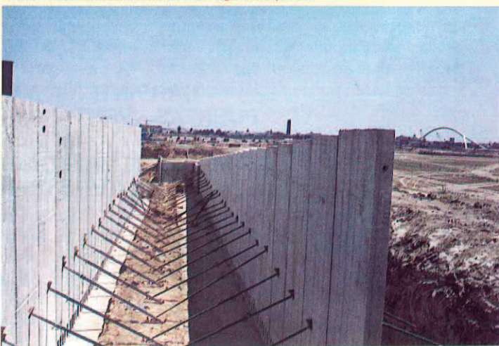
Placa - Muro de contención. Zona Lago en Expo-92.
