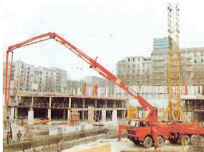
BOMBAS DE HORMIGONAR SOBRE CAMION
