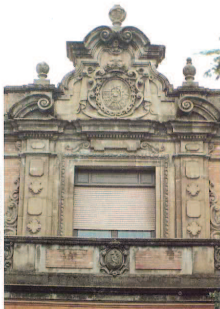
Detalle de la fachada.
