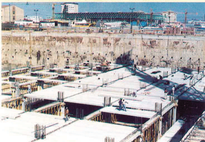
Vista general forjados (Jacenas - placas). Proinsur - Alcampo II. Sevilla.
