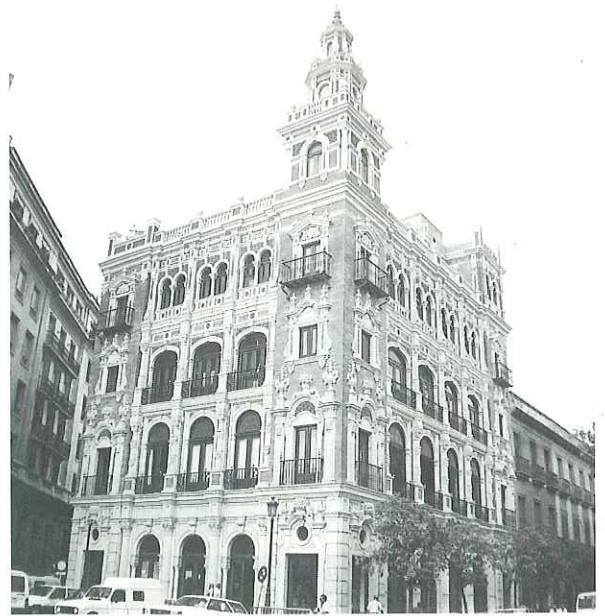
Edificio Telefónica (Plaza Nueva)
