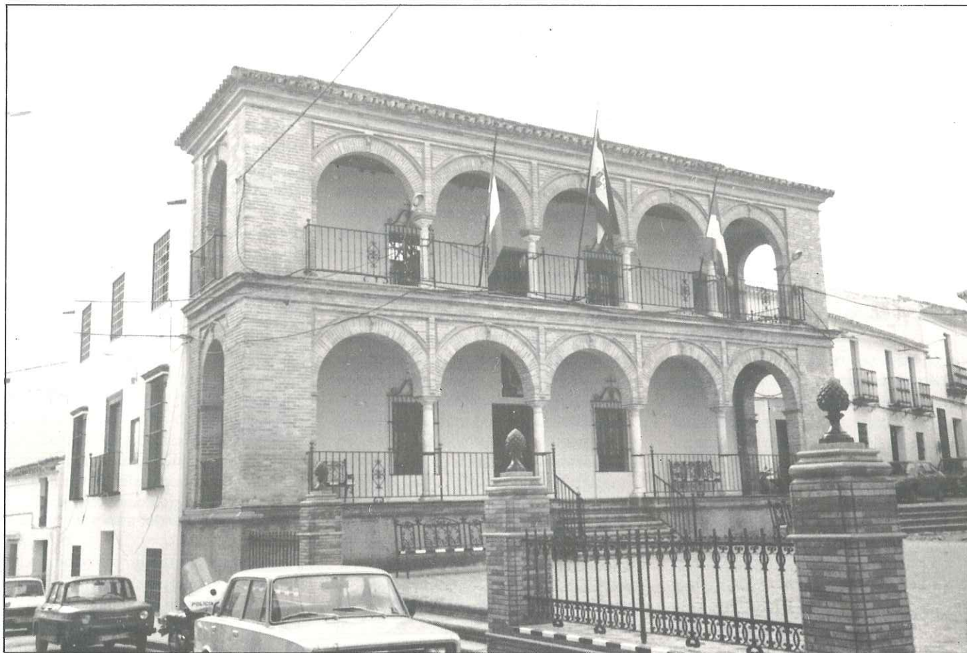
Estado actual del edificio.
