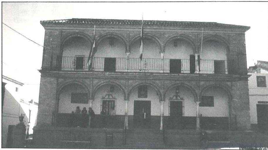
Estado de la fachada principal, antes de acometerse las obras.
