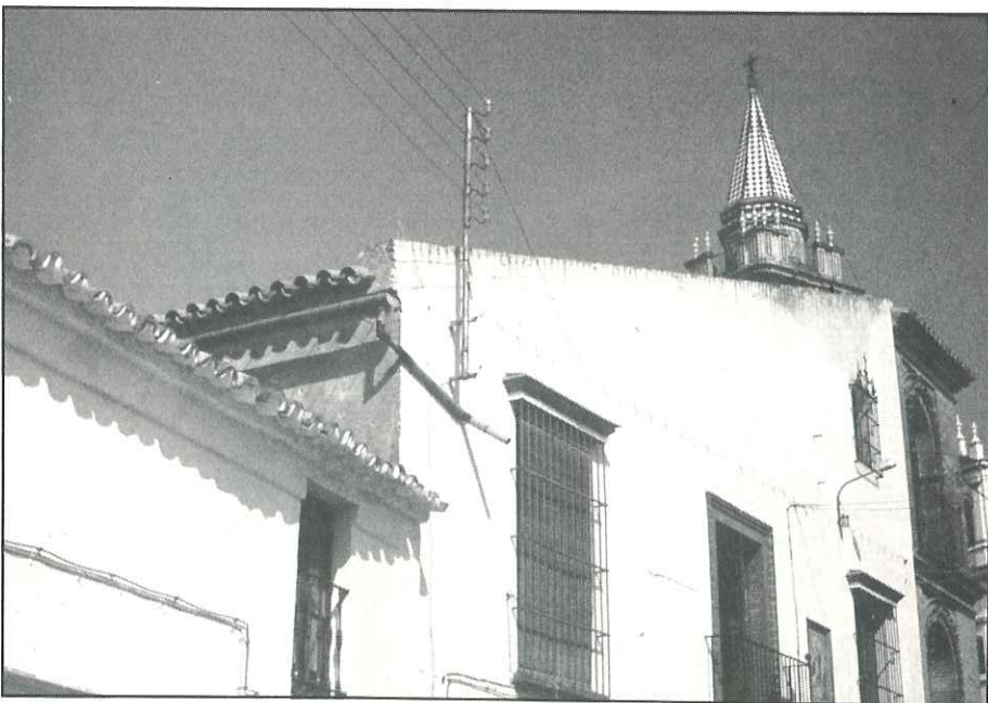
Fachada de la calle Ayala, antes de la remodelación.
