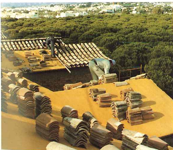
AISLAMIENTO IMPERMEABILIZACION DE UNA CUBIERTA TRADICIONAL
