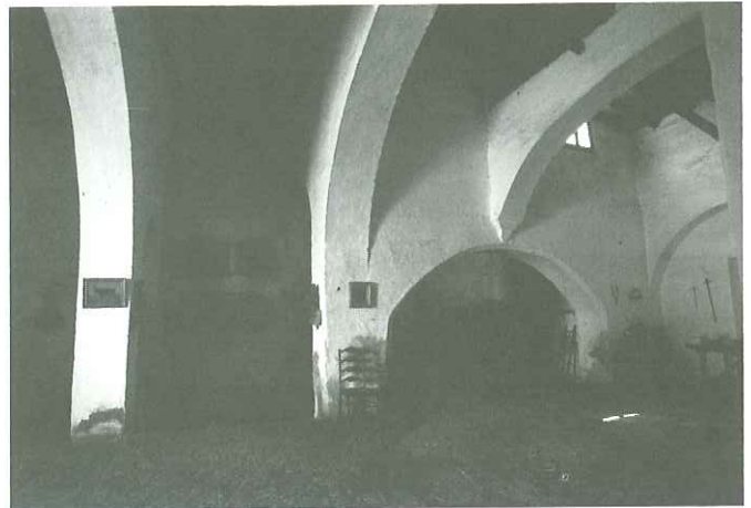
Hacienda de Benazuza. Sanlúcar la Mayor. Interior del molino
