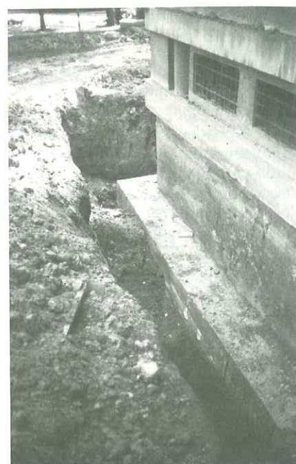
Detalle del realce de cimentación recientemente ejecutado en la 1.ª fase de su restauración (1986).
