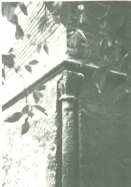
Detalle que recoge el capitel y parte del fuste de una de las cuatro columnas pétreas que decoran las esquinas del primer cuerpo de la torre.
