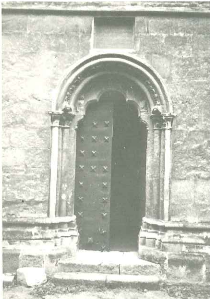
Puerta de acceso situada en la cara norte de la torre. Sobre la clave de los arcos concéntricos se advierte la lápida que recoge la fecha de la construcción y el elogio de la misma.
