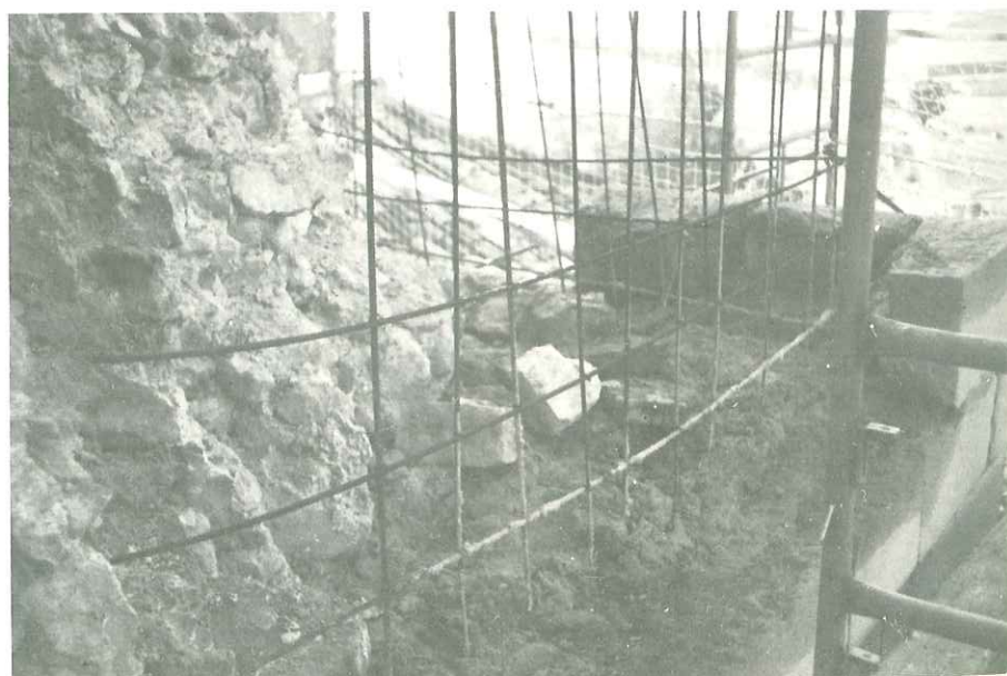
Emparrillado de atado de la esquina sujeto a los cosidos
