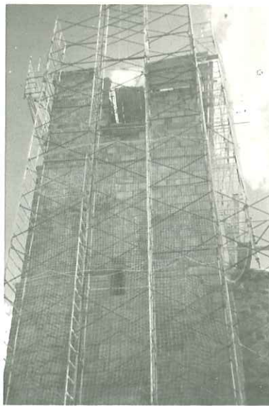
Diferentes aspectos de la elevación de las fábricas de sillería
