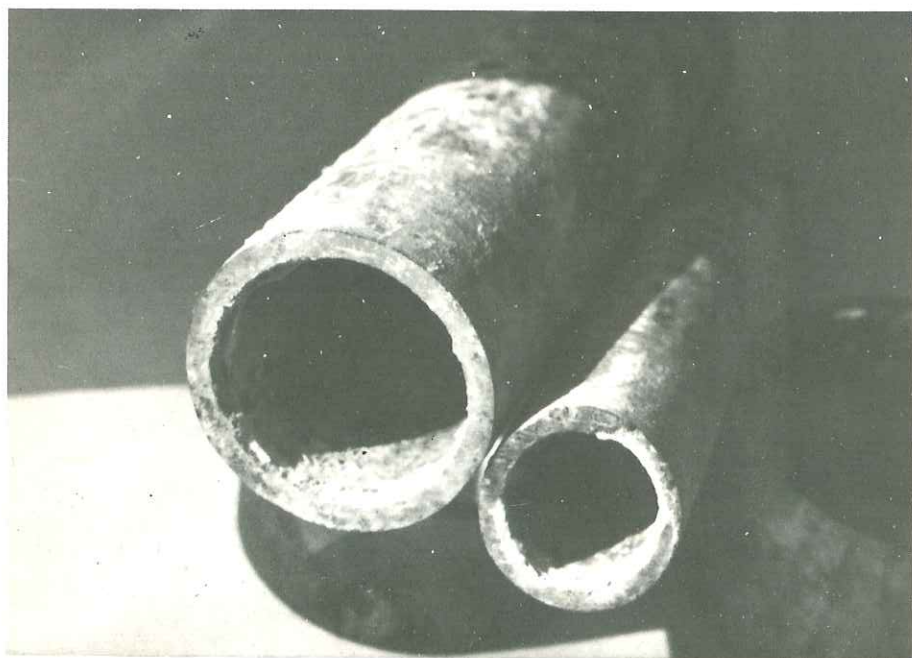
Figura 3.—Secciones de tubos de acero galvanizado protegidas por el efecto de sacrificio del zinc
