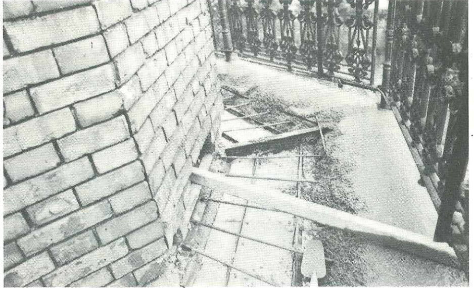
Reconstrucción de la balconada principal mediante ménsulas metálicas y relleno de hormigón.
