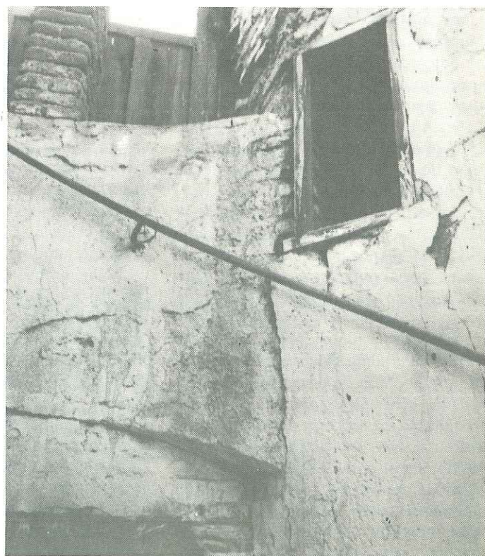
Dintel del hueco de planta baja
